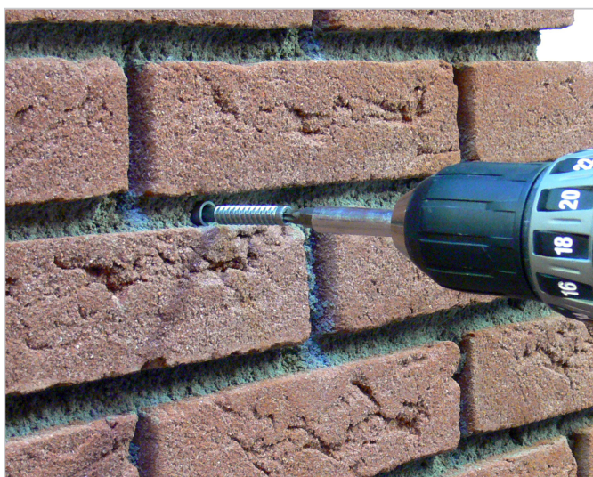
Draai de schroef in de plug tot circa 1 cm onder de kraag van de plug.
